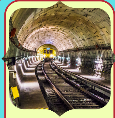
BAJO TIERRA UNDER GROUND
